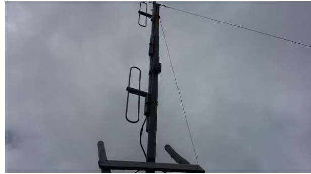
Figura 9. Colocación Nodo Router. Fuente: Autoría propia.
