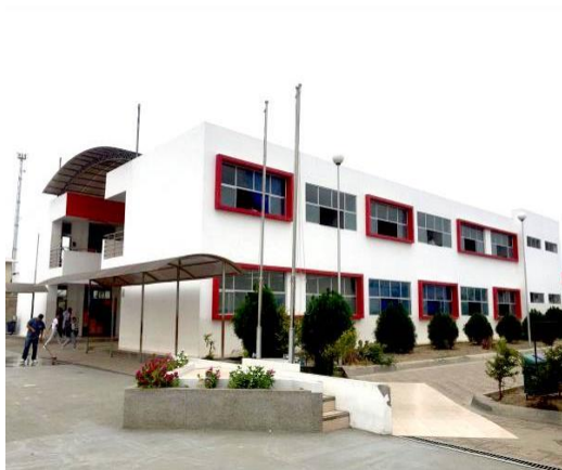
Figura 2. Bloque de aulas UEM Manta, Región Costa. Fotografía: Autor, 2020.
