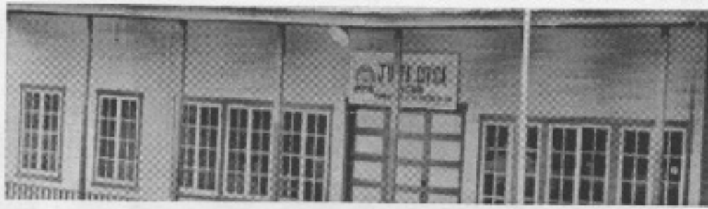
Figura 28.- Antiguo Sindicato de Obreros y Actual Junta Cívica de Ancón ( INPC )
