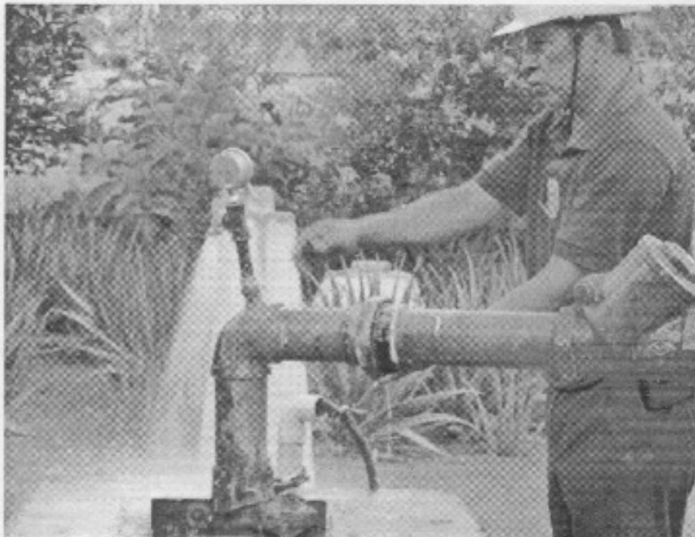
Figura 40.- Uno de los pozos que se encuentran actualmente en Manglaralto
