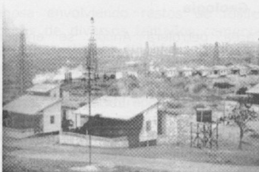
Figura 4.- Campamento Ancón (1910-1920) Fuente: (Gobierno Autónomo Descentralizado Parroquial San José de Ancón, 2011)
